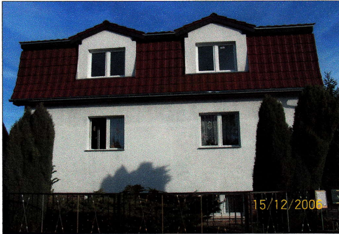
Fassade ist noch nicht komplett fertig, aber der Winter kann kommen.
